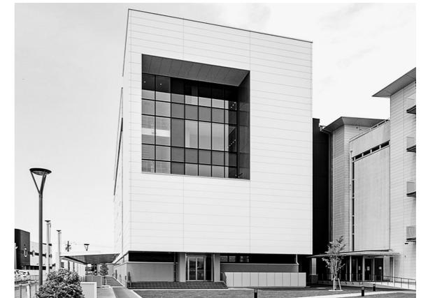
新棟は、科学計測用デジタルカメラと病理デジタルスライドスキャナの組み立てや調整などの生産機能を集約し、スペースを拡張することで需要拡大に対応。段差のない渡り廊下で既存棟と接続し、人や物の移動を効率化して生産性向上。部屋内部の柱をなくし、電源や空調などの配置を工夫し、レイアウトの自由度を高めて生産量や生産品目の変化に対応しやすい設計となっている。また、集約により発生する既存棟の空きスペースを利用し、半導体故障解析装置の生産を拡大する。
