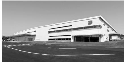
同工場はビル用アルミ建材商品の製造拠点で、新建屋では社内の機械製造部門による合理化設備での集約生産、自動化工程の拡大、データ連動したラインづくりなどのモノづくり改革により、製造コストを従来の25%削減。また、ユニットロード化やモーターシフトによるロジスティクス改革も含め、発注から納品までのリードタイムを最大11日短縮している。さらに、「働きがいのある工場」をコンセプトに高断熱外皮や断熱性・換気性に優れた窓、調光照明、高効率空調を採用してCO2排出量を30%削減。太陽光発電(発電能力1時間あたり1100kWh)と再生可能エネルギー調達によってCO2排出実質ゼロを実現するほか、雨水の利用も行い、地球環境や働く人にやさしい工場を目指す。
