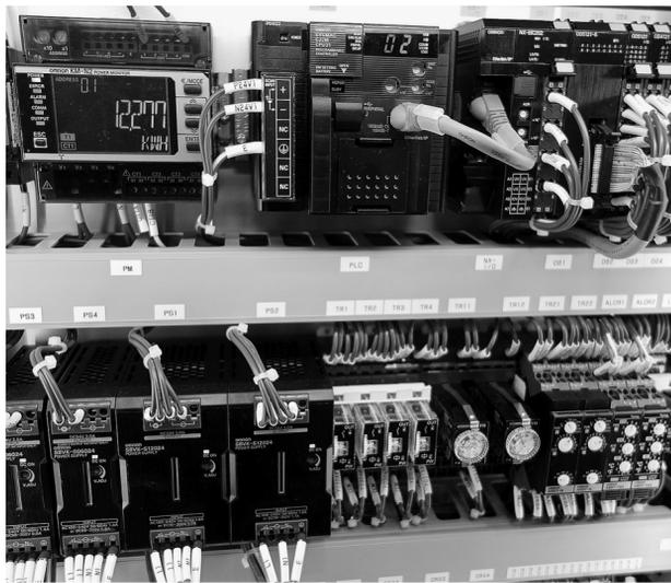
はねじ式の使用が多い。接続信頼性が高いというのが大きな理由だ。スプリング式はケーブルを押し込めただけで配線作業が完了し、ねじ締め作業や締め加減も不要など、省力化効果は大きい。また配線作業が不慣れた初心者であっても簡単に作業ができることから、熟練作業員不足を補って技術習得に時間がかからず、懸念されていた振動での配線の緩みや経年での信頼性に対する心配も使用実績を重ねることで払拭され、採用加速への追い風になっている。そして、このスプリング式もここきて大きく変化している。そのひとつが配線工具不要で配線作業が可能になったことだ。
