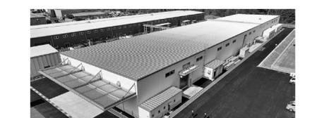
新工場ではノンフロン断熱不燃パネル「ジェネスタ」を生産し、半導体クリーンルームや低温流通倉庫向けに供給する。工場棟は、鉄骨造平屋建て、延床面積4767平方メートル。厚生棟は、木造平屋建て、延床面積223平方メートル。
