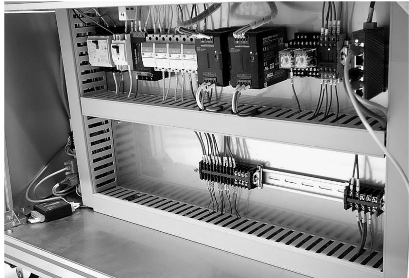
端子台に配線接続方法は、日本でも主流になっていくねじ式、欧米でも主流になっている圧着端子を使用しないスプリング式(ねじレス式)という大きな2つの方式がある。またねじ式の採用が多いのは、人手不足から配線接続作業の省力化対策として、スプリング式の採用が増えている。日本ではねじを使用した丸型圧着端子台(丸端)が長年使用され、定番となっている。特に高圧・大電流用途や振動の多い用途ではねじ式の使用が多い。接続信頼性が高いというのが大きな理由だ。スプリング式はケーブルを押し込むだけで配線作業が完了し、ネジ締め作業や締め加減を必要とせず、省力化効果は大きい。また配線作業が慣れない初心者であっても簡単に作業ができることから、熟練作業者がなくても配線技術習得に時間がかからず、懸念されていた振動による配線の緩みや経年での信頼性に対する心配も使用実績を重ねることで払拭され、採用加速への追い風になっている。
